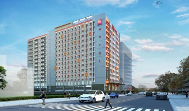
TÒA NHÀ VĂN PHÒNG HADO AIRPORT BUILDING
