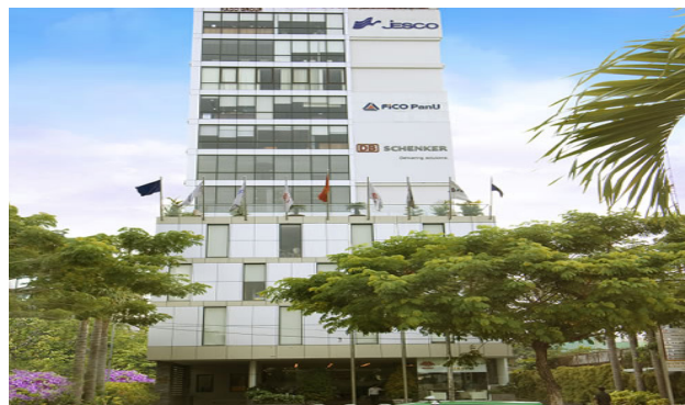
TÒA NHÀ VĂN PHÒNG HADO SOUTH BUILDING
